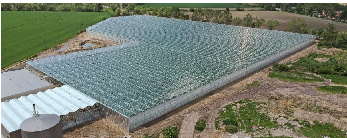
51. ábra: 5,0 hektár területű termásvíz-fűtéses üvegházrendszer
