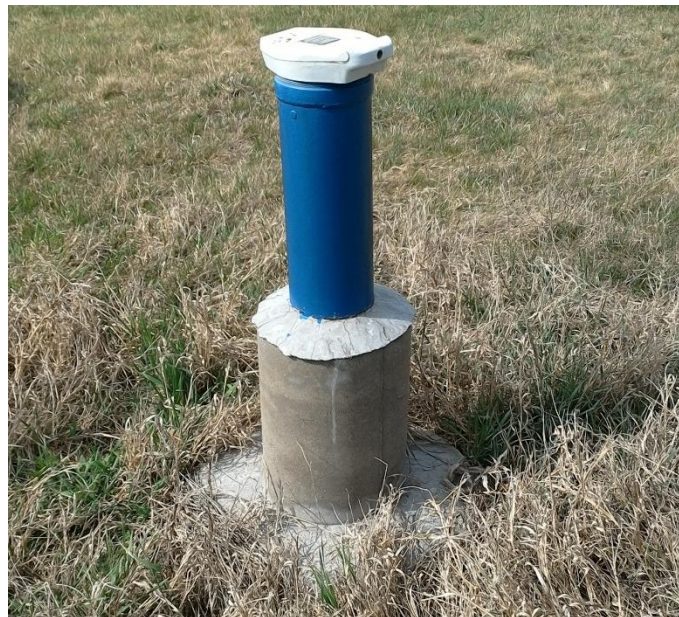
12. ábra: Jellemző kútfejkialakítás a monitoring kutak esetében
